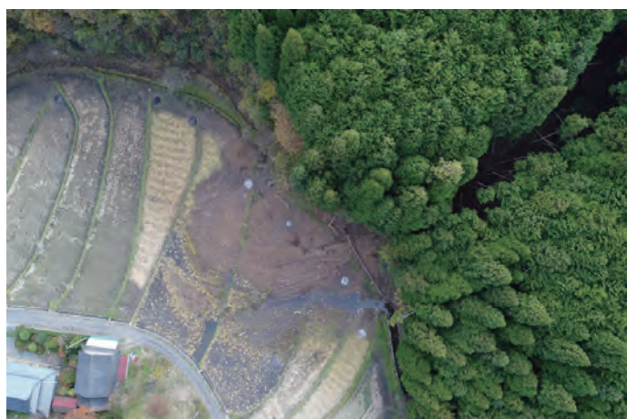
ドローンで被災の状況をすばやく確認
