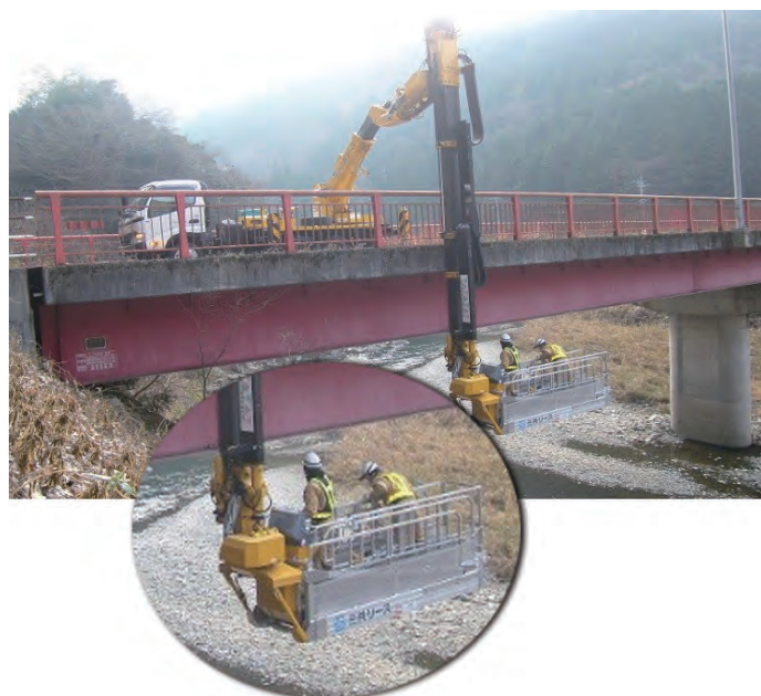
橋の劣化度を点検中 橋の下側の確認は、専用の車両を使います
